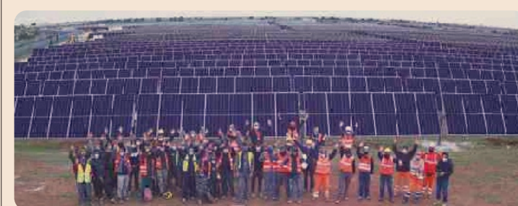
Termine dei lavori e messa in esercizio dell'impianto
