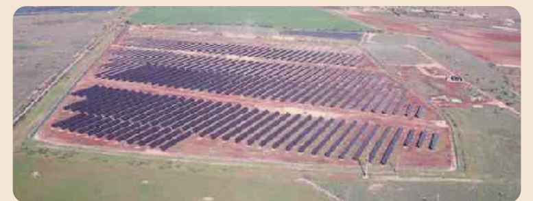
Vista aerea dell'impianto
