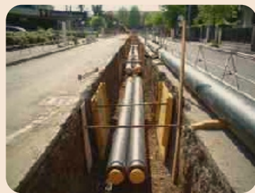
Lavori per la posa della rete. Gli aggiornamenti sono tracciati su beabrianza.it
